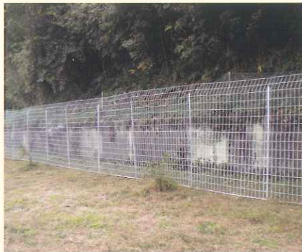
滋賀県大津市 距離：9000m/施工時期：平成22～23年
