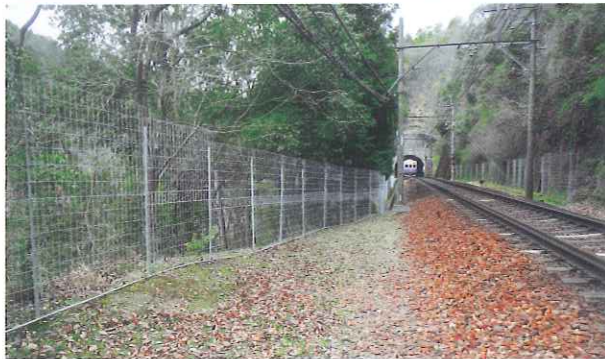
能勢電鉄(株) 妙見線 猪・鹿進入防止柵
